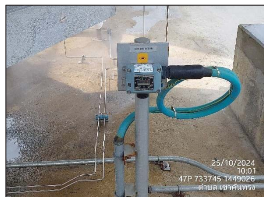
ภาพที่ 38 ระบบตรวจจับการรั่วไหลของก๊าซ
