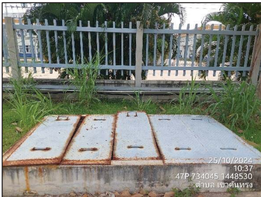
ภาพที่ 15 จุดระบายน้ำฝนเข้าสู่ ระบบระบายน้ำฝนของนิคมฯ
