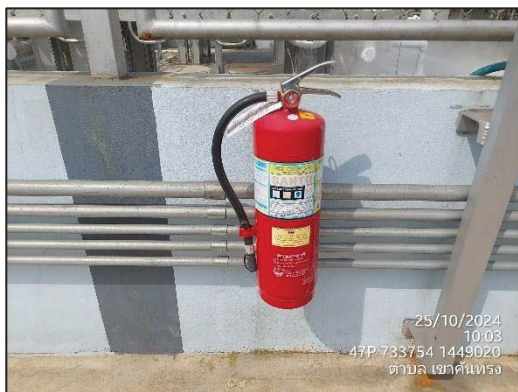
ภาพที่ 36 ถังดับเพลิงชนิดผง (บริเวณสถานีก๊าซของโครงการ)
