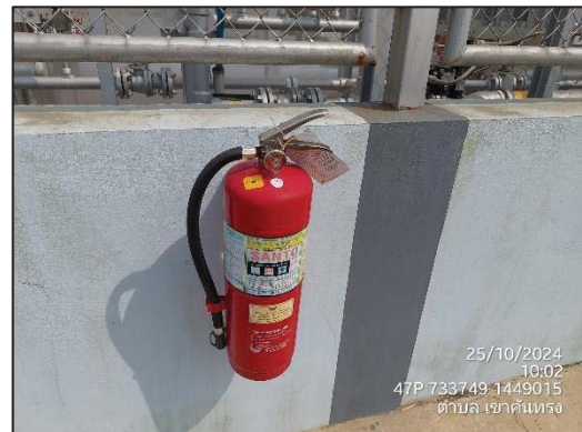
ภาพที่ 36 ถังดับเพลิงชนิดผง (บริเวณสถานีก๊าซของโครงการ)
